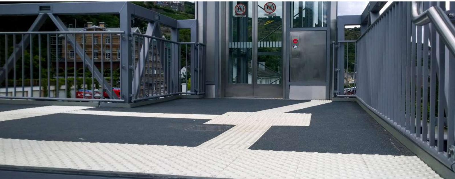
**TacPad® und TacGuide® sind thermoplastische taktile Markierungen, mit deren Hilfe die Sehbehinderten sich selbständig und sicher im Straßenverkehr bewegen können**
